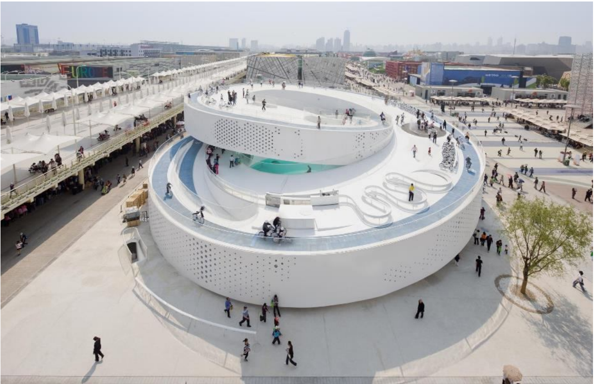
BIG, Expo 2010 Danish Pavilion, vista dall'alto. © foto di Iwan Baan
